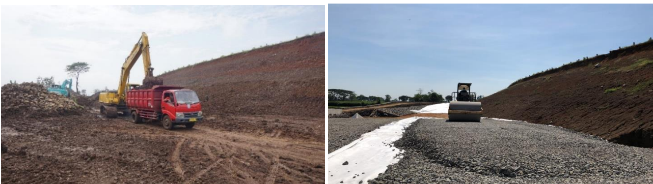
Gambar 2. Pelaksanaan rehabilitasi pada Bendungan Lalung (a) Pengupasan lereng hilir bendungan menggunakan excavator . (b) Proses pemadatan material filter ( gravel ) pada horizontal drains menggunakan vibro roller .
