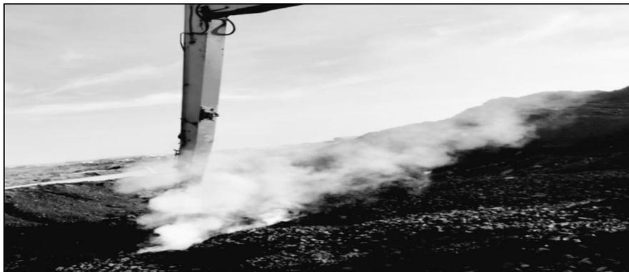
**Gambar 3. Perapian Timbunan Batubara yang Terjadi Swabakar Menggunakan Alat Bulldozer Komatsu D60P Pada Temporary Stockpile Mahoni**
